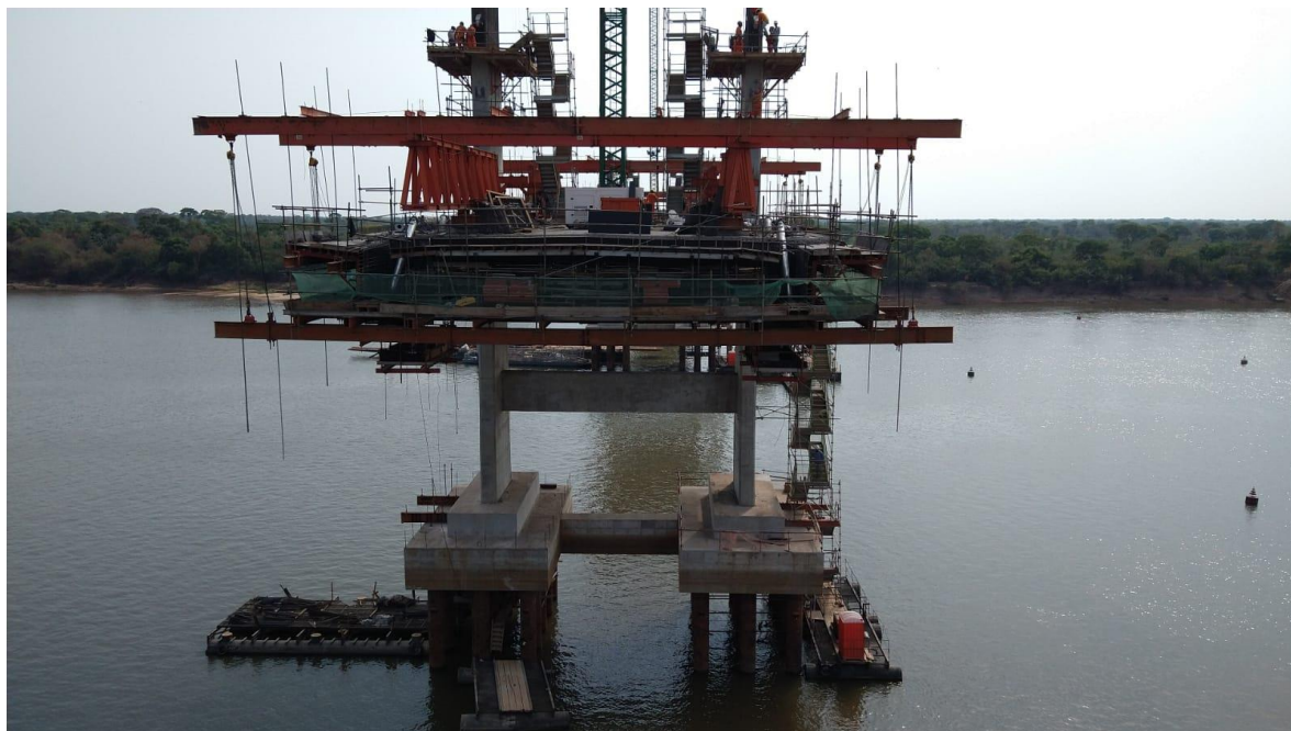
Figura 14 – Obra da Ponte no Rio Araguaia.
