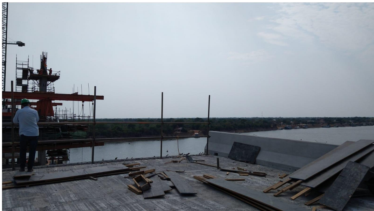
Figuras 12 e 13 – Obra da Ponte no Rio Araguaia.
