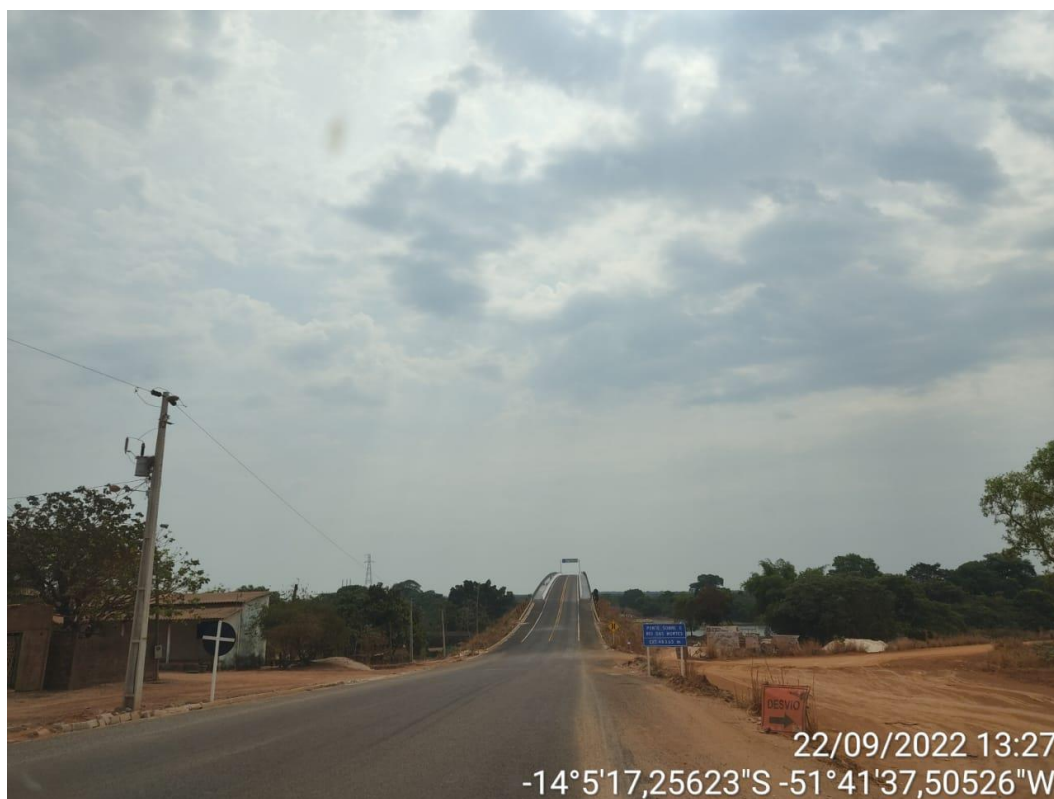
Figuras 25, 26 e 27 – trechos da Ponte no Rio das Mortes, na MT 326.
