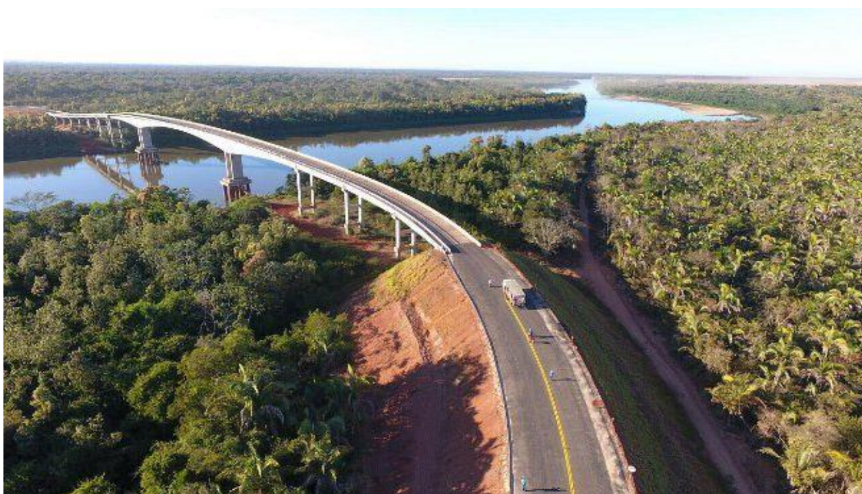
Figura 19 – Ponte do Rio Araguaia. Fonte: GCom
