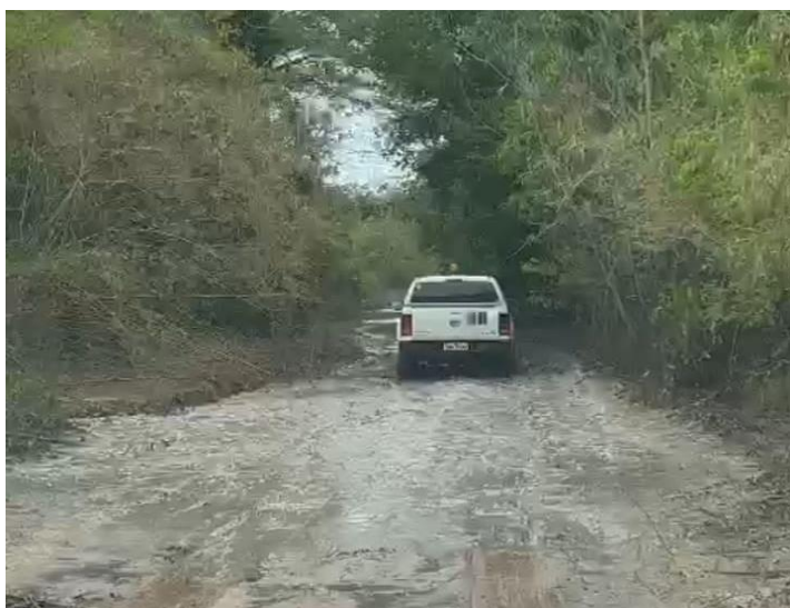
Figura 15 – trecho de leito natural da BR-080 projetada
