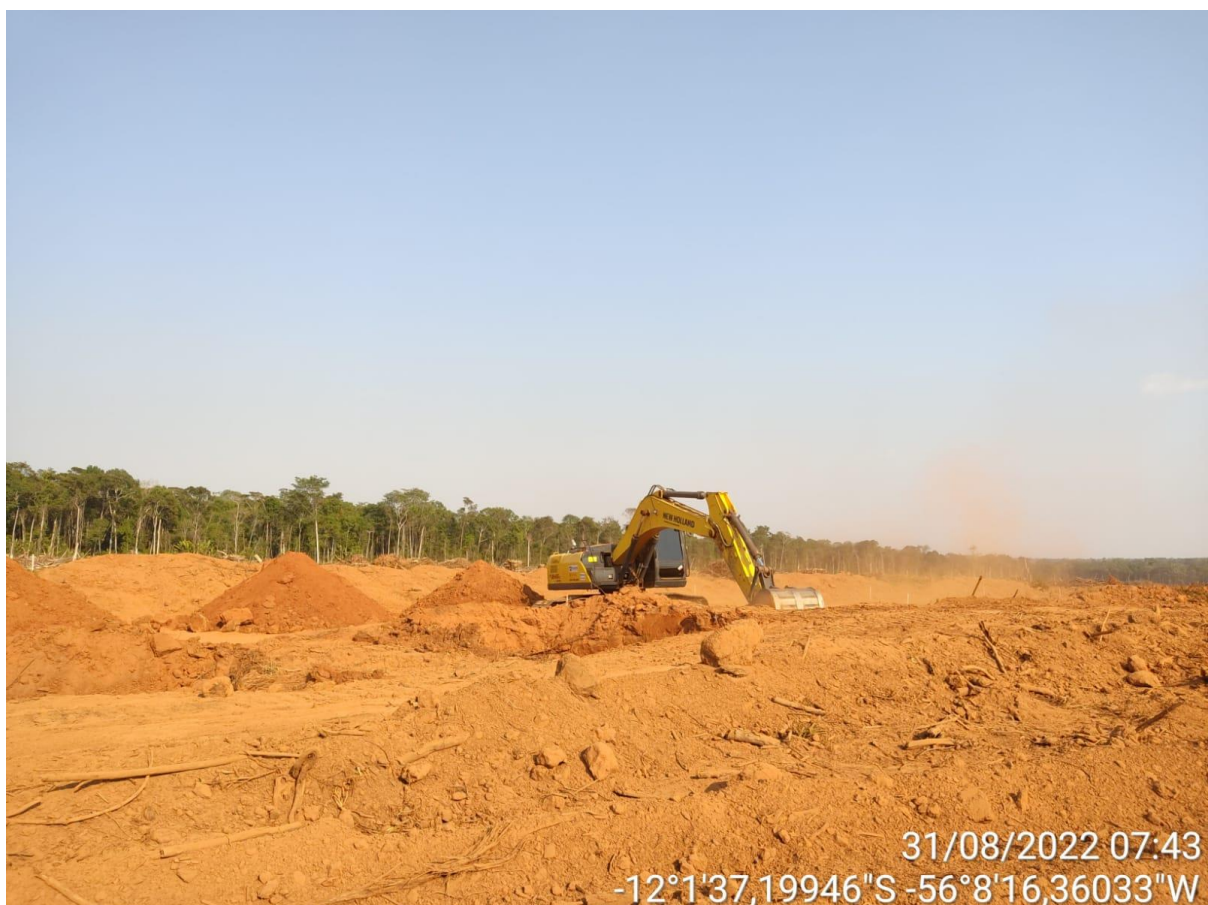
Figuras 38 e 39 e 40 – obras no trecho 1 da MT 010.
