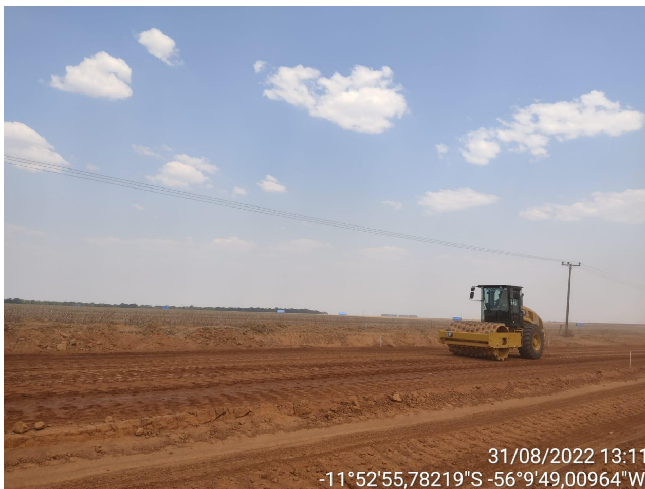
Figuras 48 e 49 – obras no trecho 2 da MT 010.
