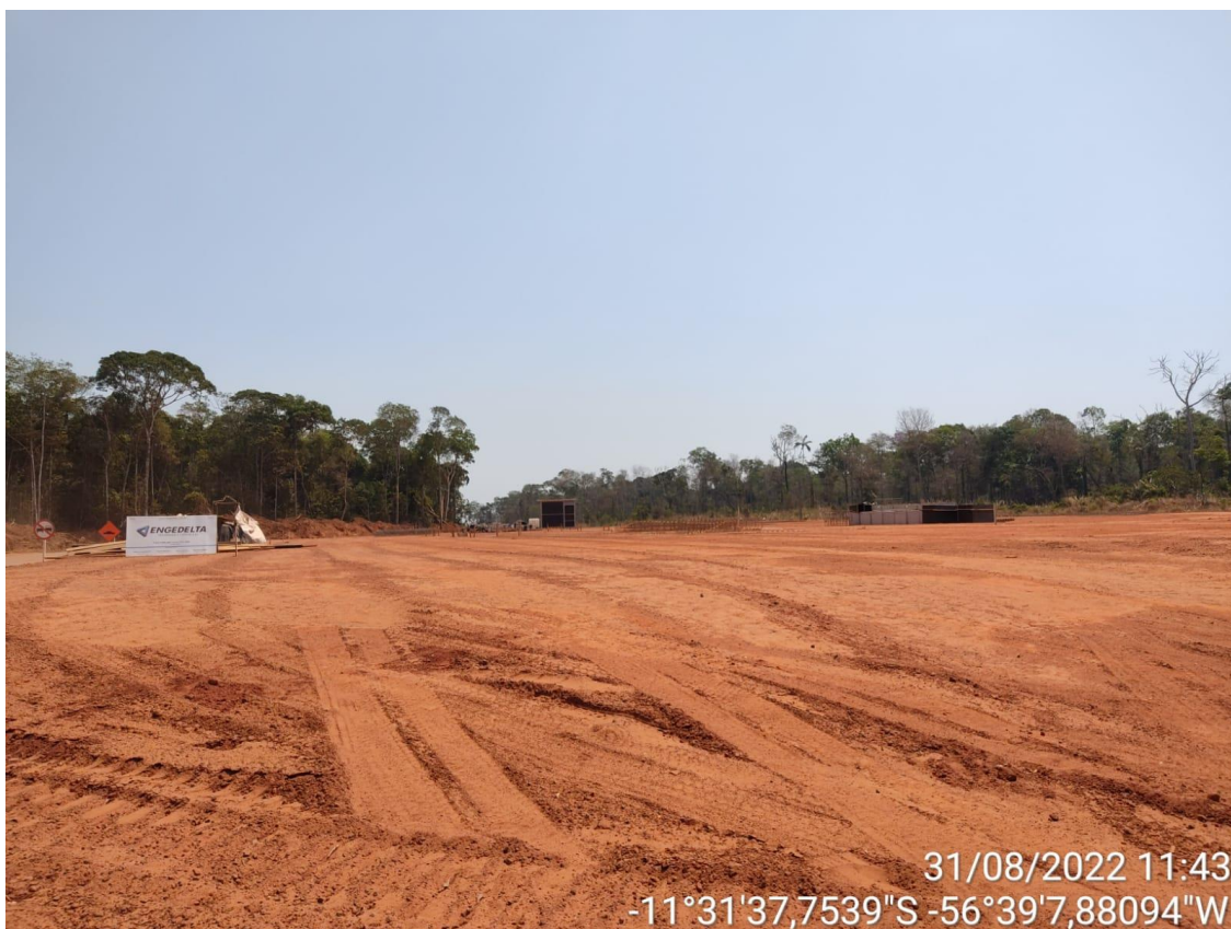
Figuras 25 e 26 – construção de praça de pedágio.
