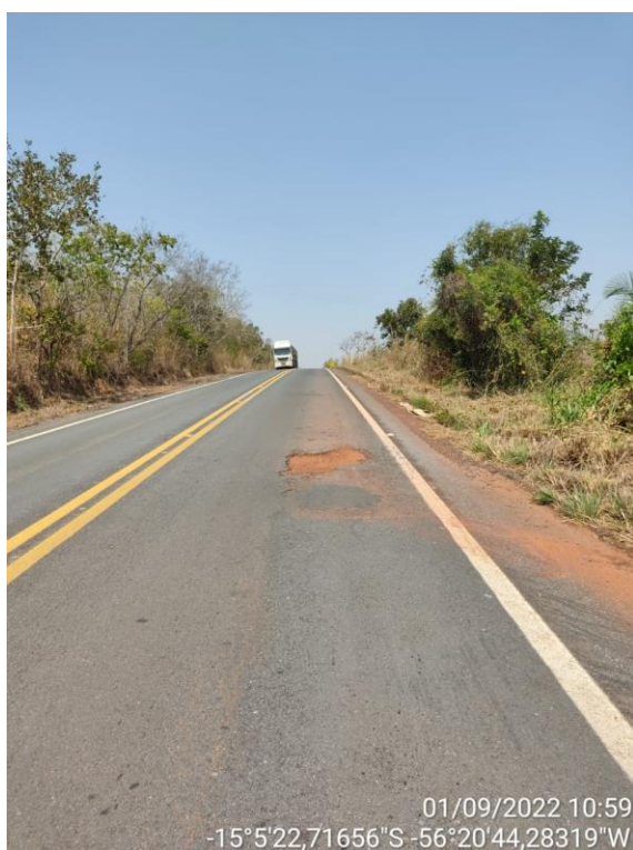
Figuras 2, 3, 4 e 5 – defeitos no pavimento
