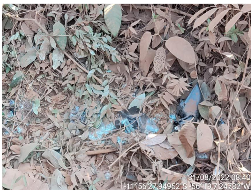
Figura 62 – indícios de capotamento na ponte nº 2.
