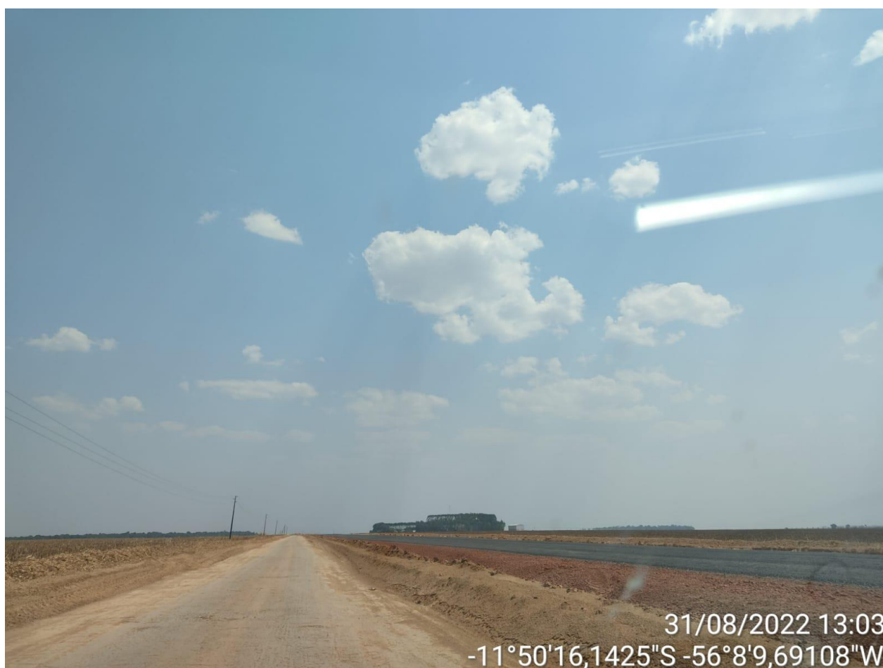
Figuras 43, 44 e 45 – pavimentação e obras no trecho 2 da MT 010.
