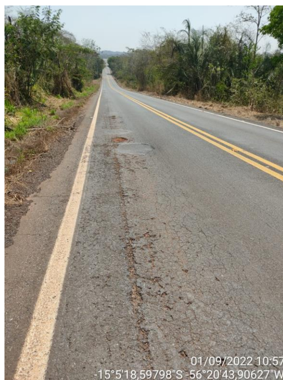
Figuras 2, 3, 4 e 5 – defeitos no pavimento
