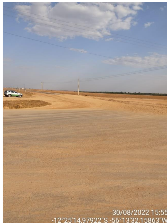
Figura 15 – entroncamento MT 010 – MT 484
