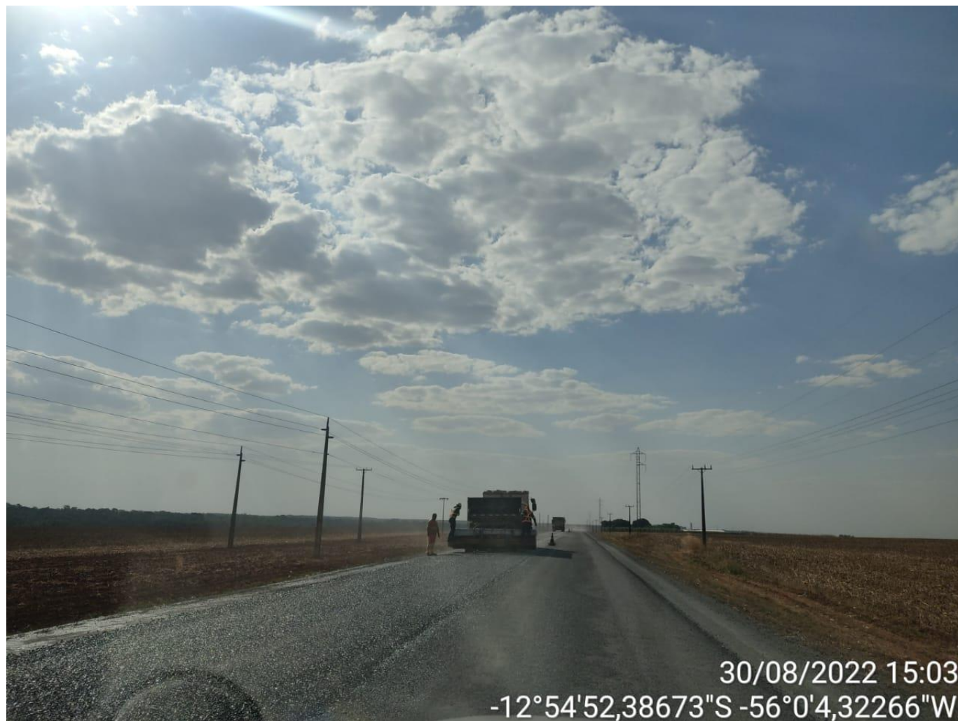
Figura 7 – Trecho em obra na MT 484
