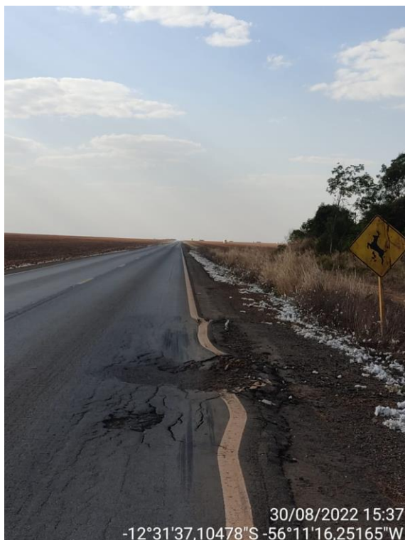
Figuras 8 e 9 – defeitos no pavimento
