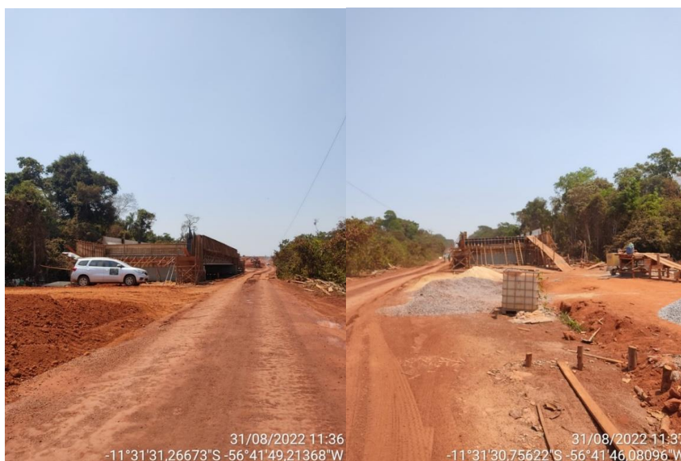
Figuras 23 e 24 – construção de ponte.
