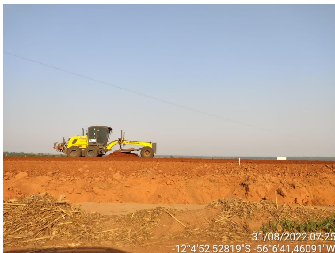
Figuras 36 e 37 – obras no trecho 1 da MT 010.
