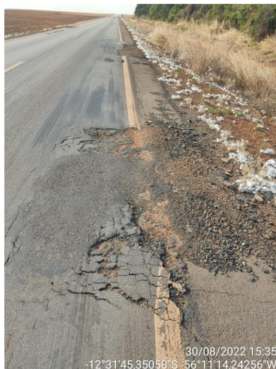
Figuras 8 e 9 – defeitos no pavimento
