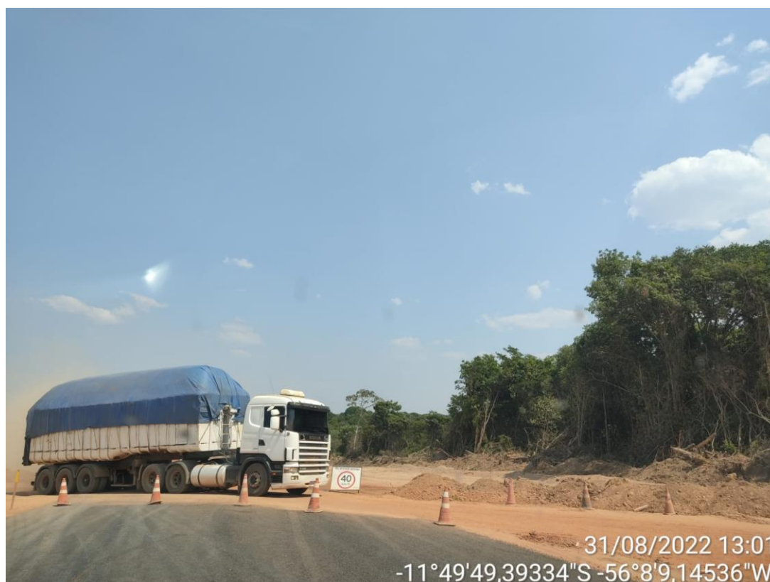
Figuras 46 e 47 – obras no trecho 2 da MT 010.
