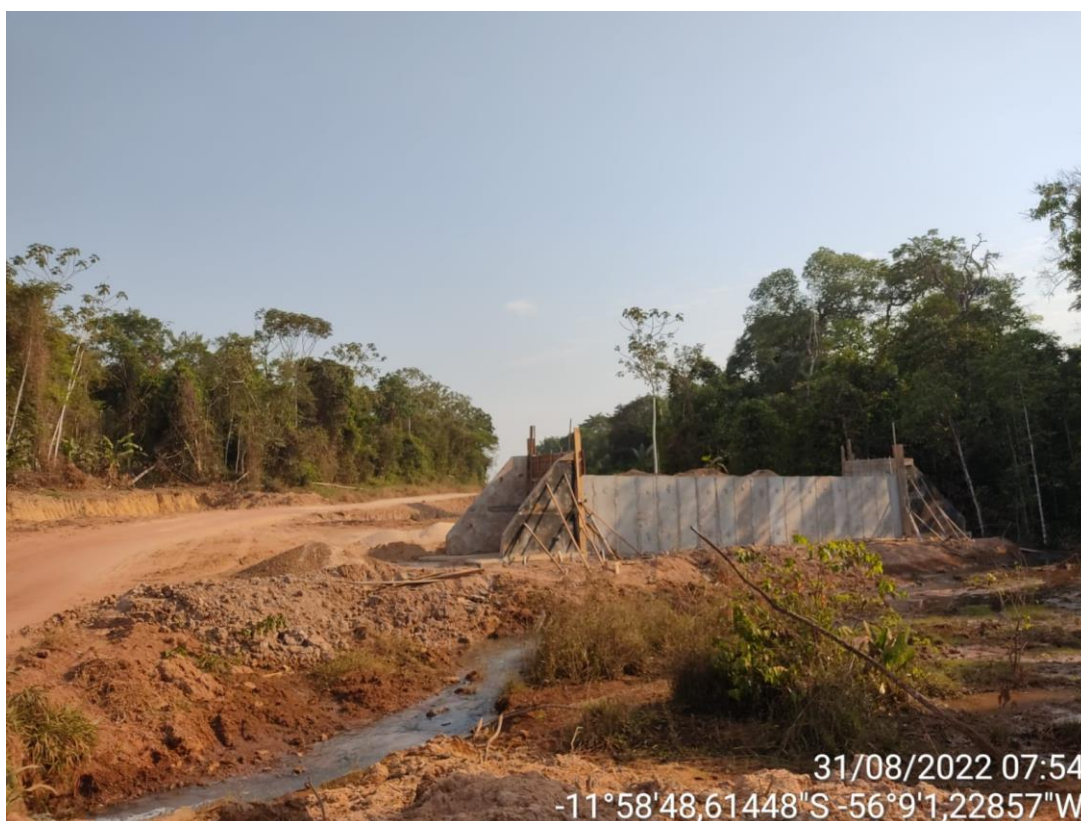
Figuras 41 e 42 – obras de bueiro e ponte no trecho 1 da MT 010.
