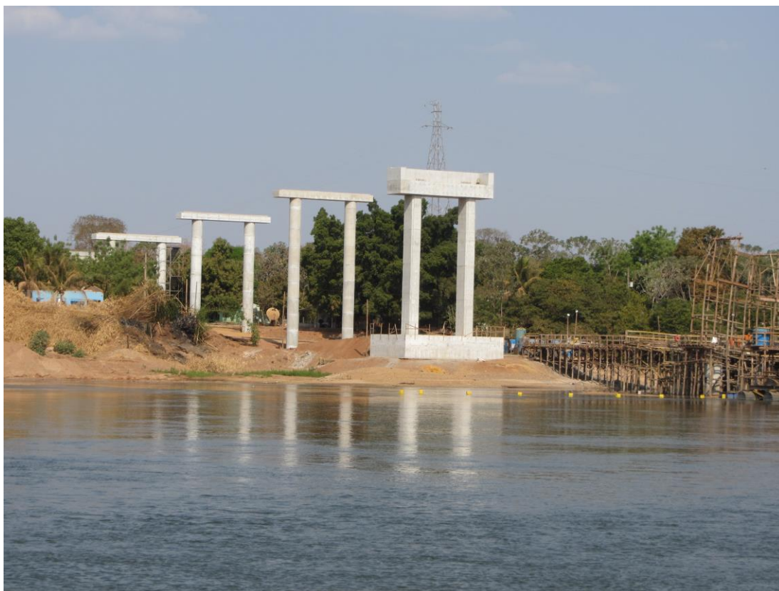
Ponte em construção sobre o Rio das Mortes – MT 326 – agosto de 2021
