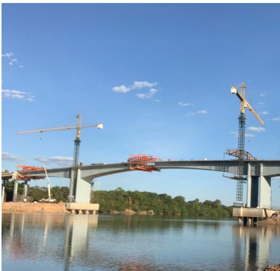
Ponte em construção sobre o Rio das Mortes – MT 326 – junho 2022
