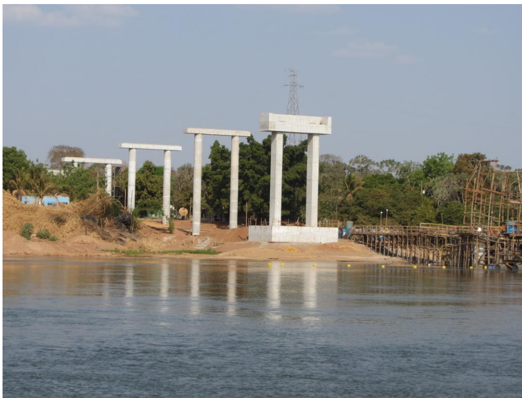
Ponte em construção sobre o Rio das Mortes – MT 326 – agosto de 2021
