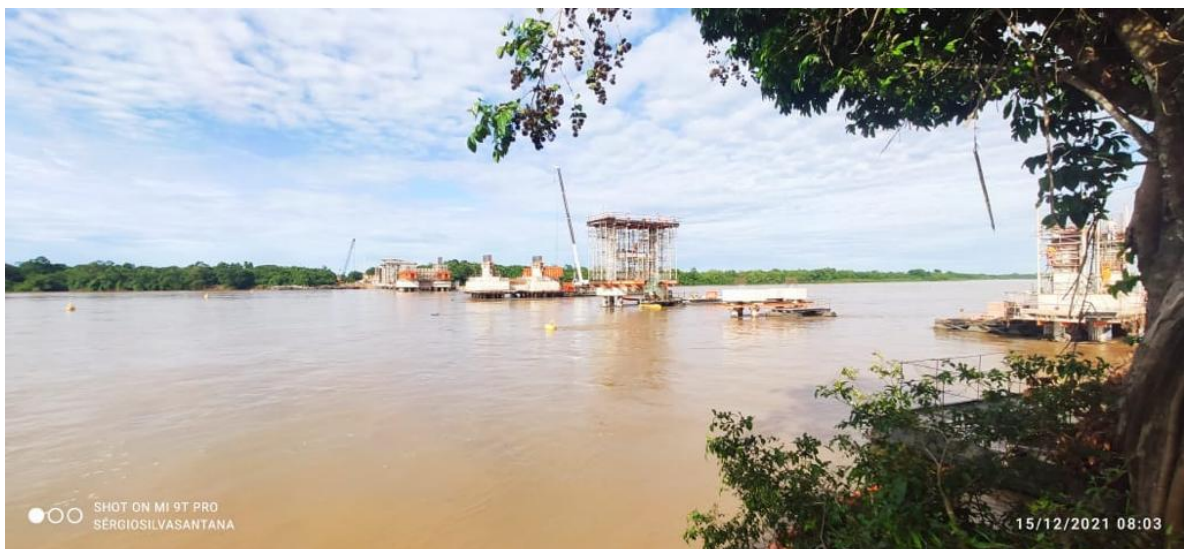
Obra da ponte do Rio Araguaia – BR 080 – dezembro 2021
