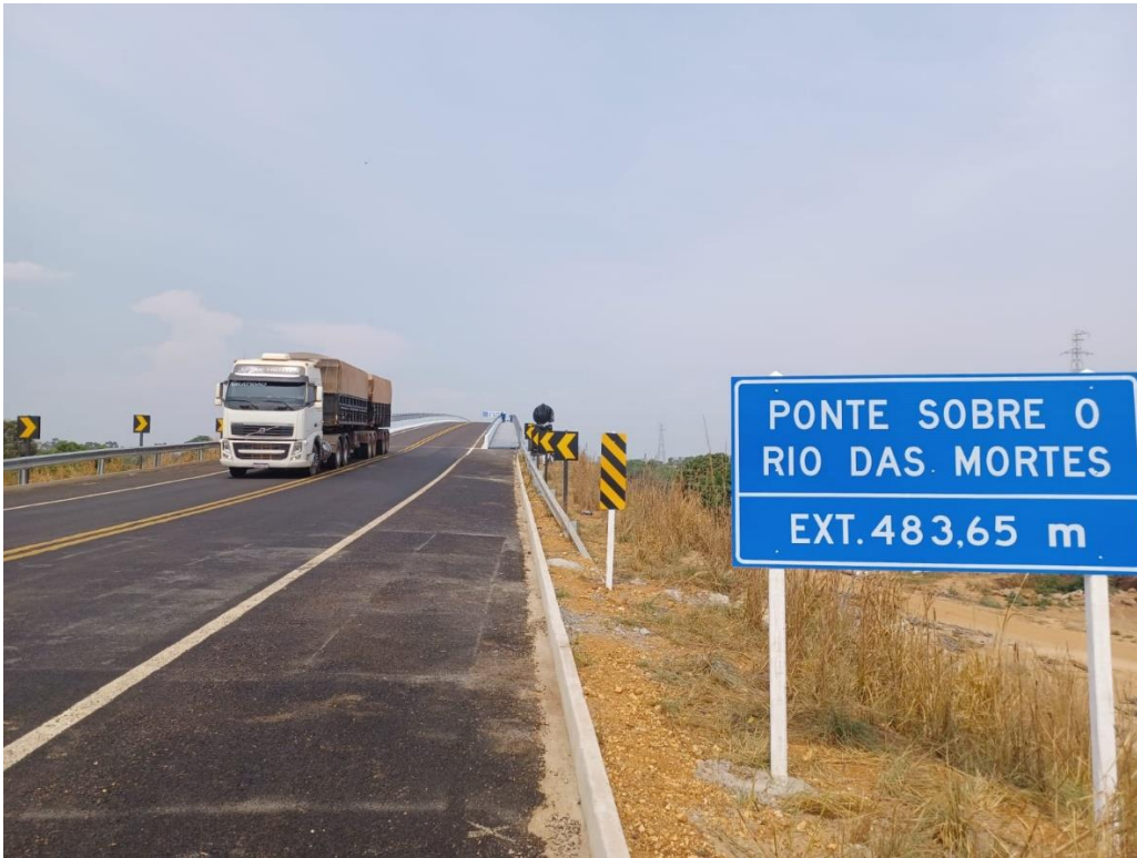
Ponte inaugurada sobre o Rio das Mortes – MT 326 – Setembro 2022
