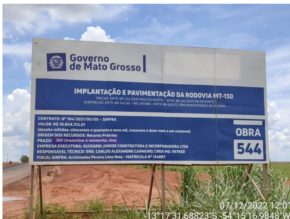
Figura 107 – obra de implantação e pavimentação.
