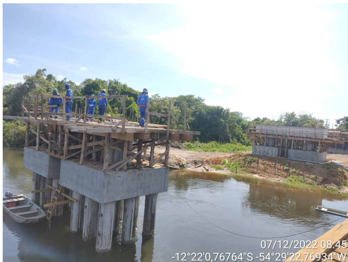
Figuras 88 e 89 – ponte sobre o Rio Von Den Steinen.
