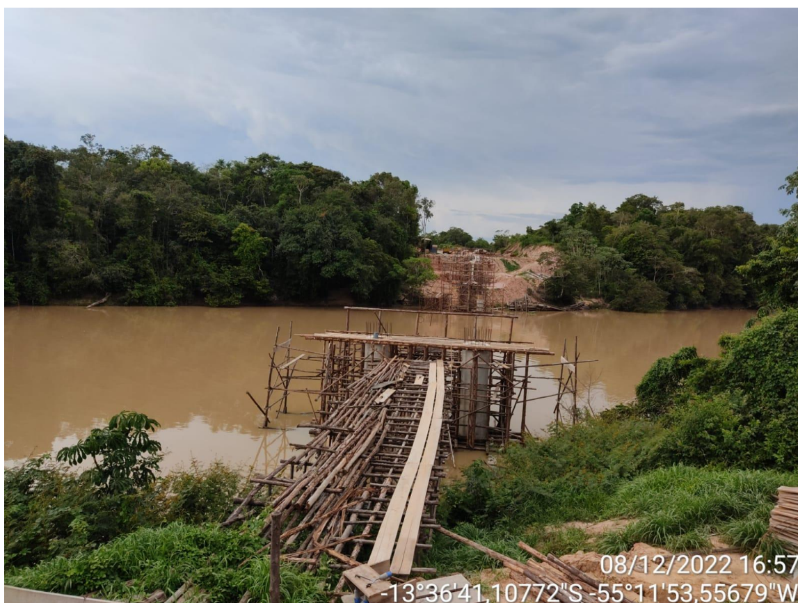
Figuras 57 e 58 – obra de construção da ponte no lado sul.
