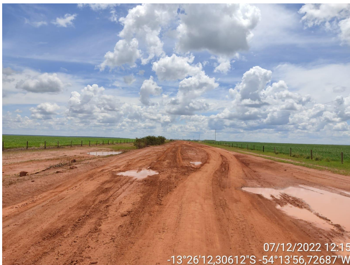
Figuras 108, 109 e 110 – trecho de implantação e pavimentação da MT-130.
