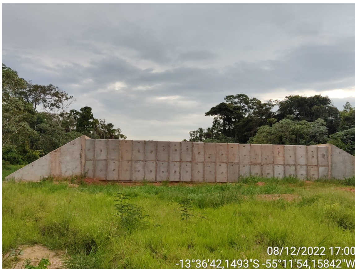
Figuras 59 e 60 – obra de construção da ponte no lado sul.
