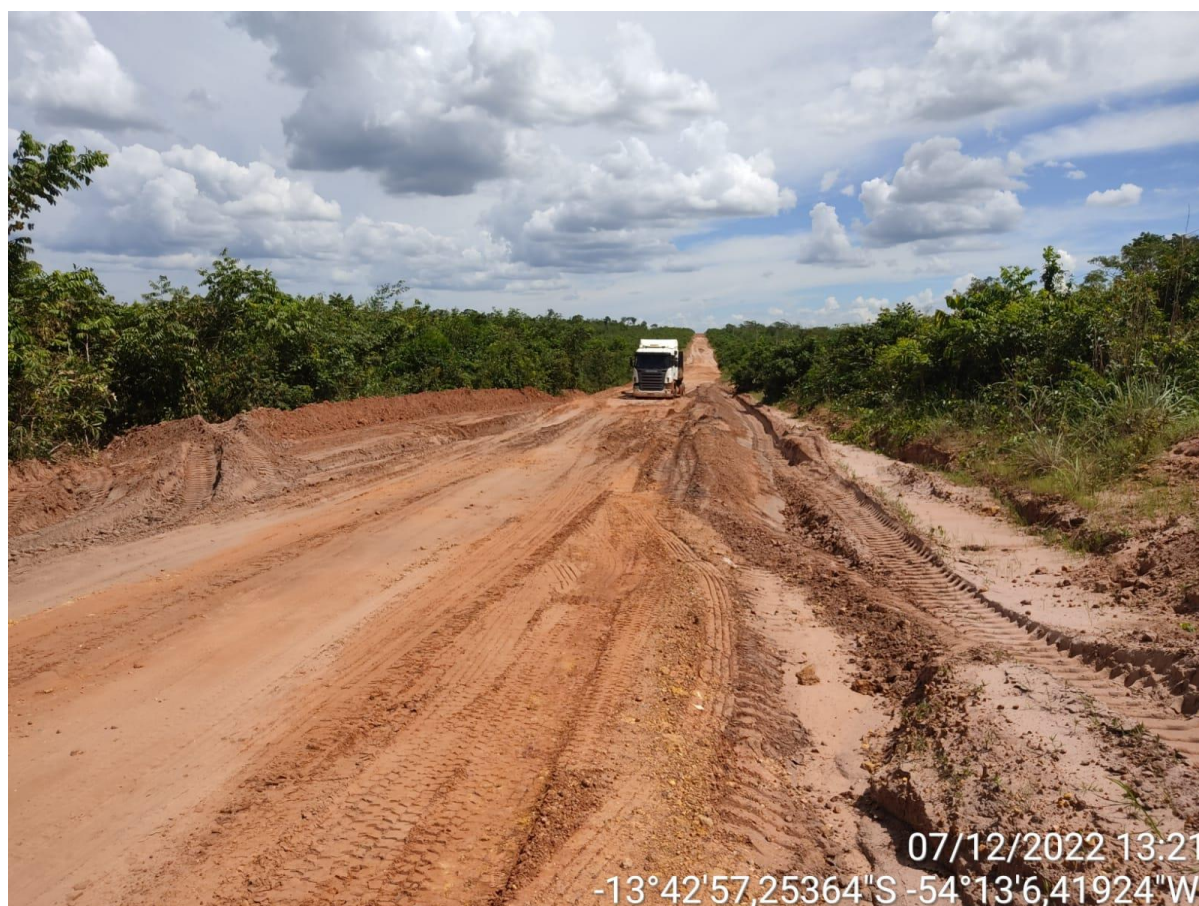
Figuras 114, 115 e 116 – trecho previsto manutenção na MT-130.
