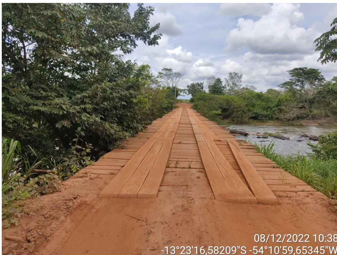
Figuras 154 e 155 – ponte sobre o Rio Jatobá.
