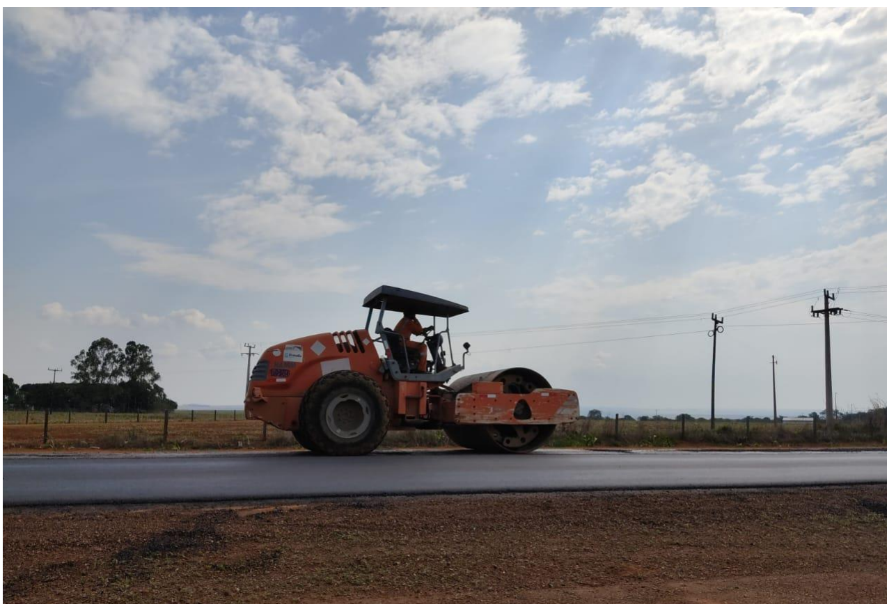
Figuras 3 e 4 – obra na MT 251.
