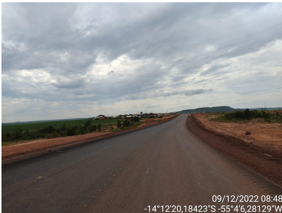
Figuras 38 e 39 - trechos pavimentados na MT-140.
