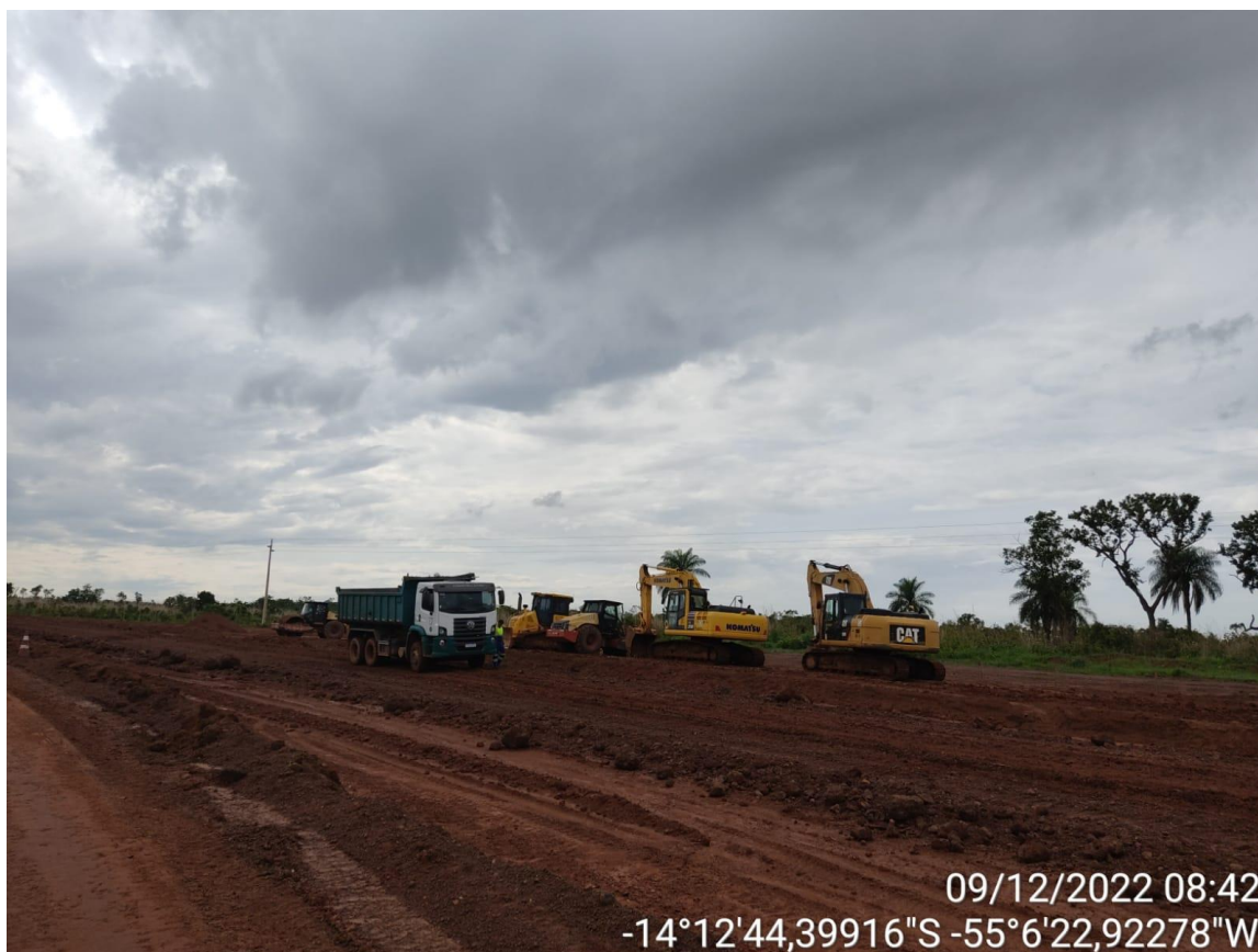
Figuras 36 e 37 - trechos em obra de pavimentação na MT-140.
