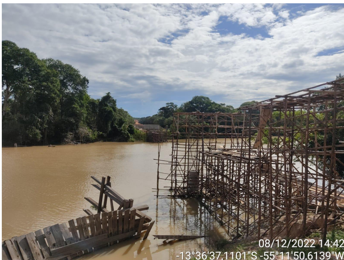
Figuras 55 e 56 – obra de construção da ponte no lado norte.
