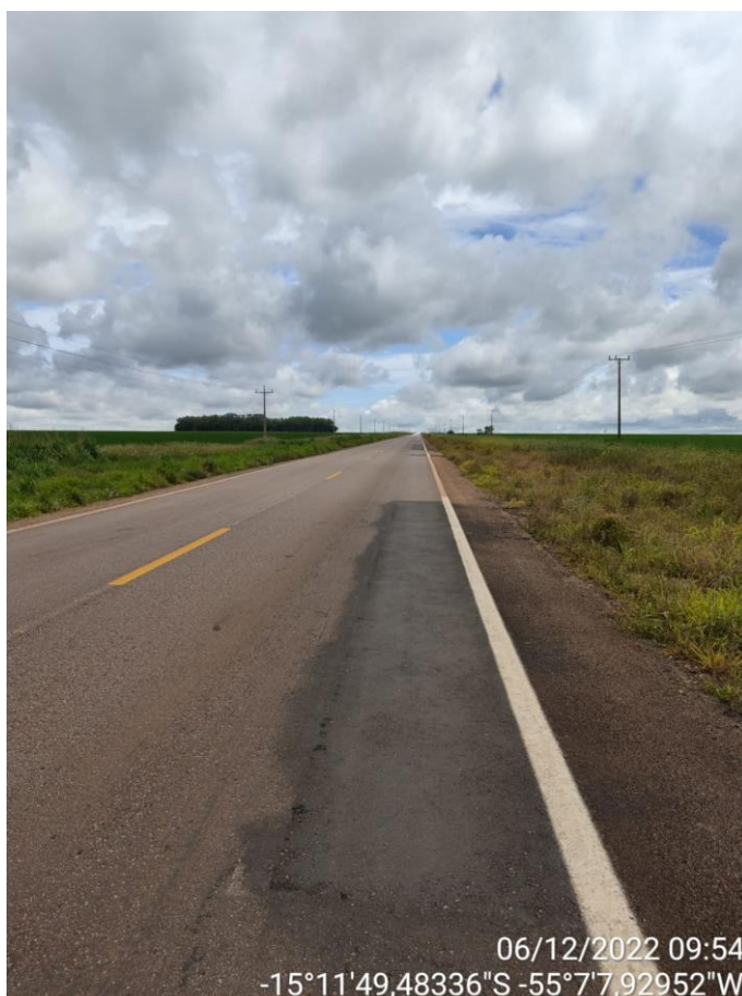
Figuras 11 e 12 – remendos no pavimento da MT-140.
