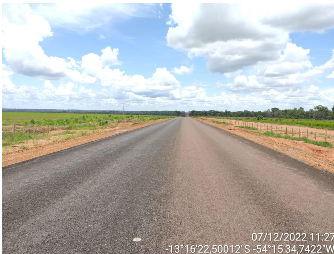
Figuras 103, 104 e 105 – obra no trecho da construtora Cavalca.
