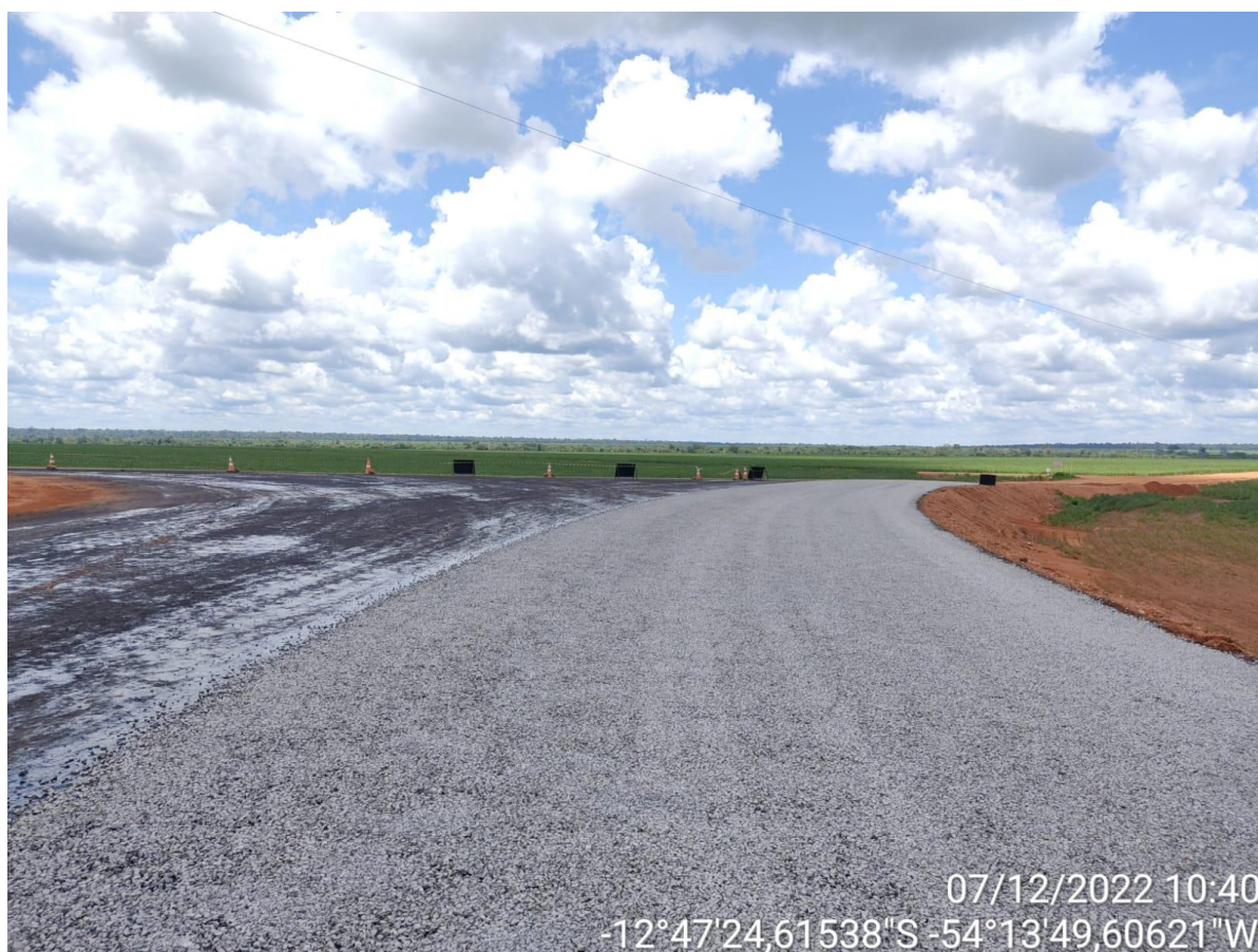
Figuras 100, 101 e 102 – obra no trecho da construtora Tripolo.
