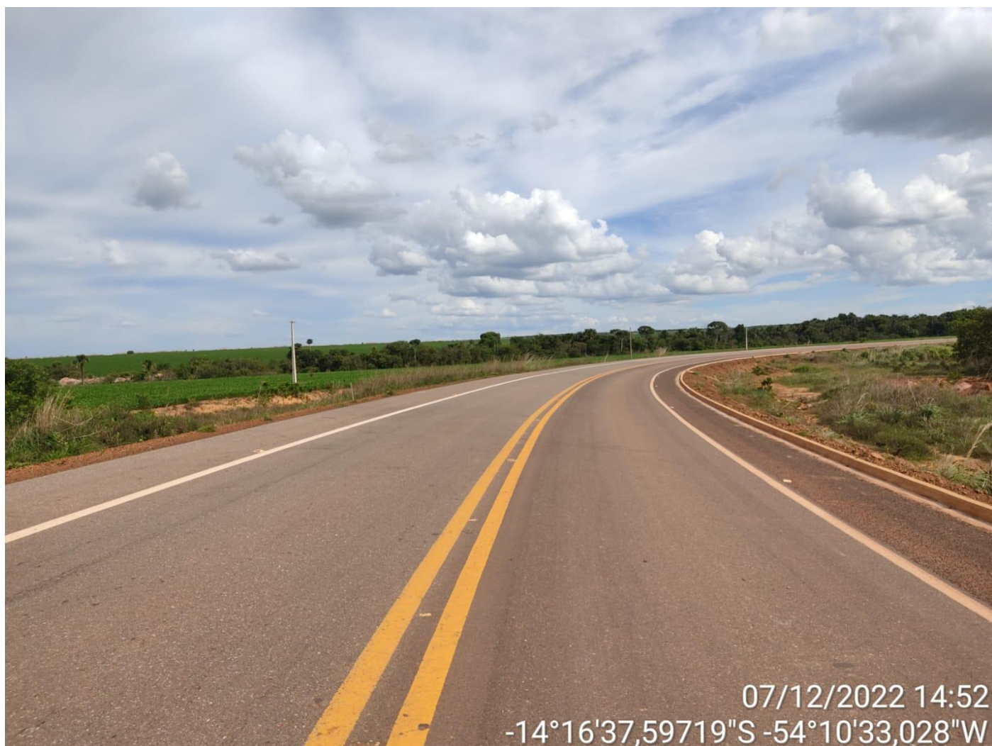
Figura 124 – trecho pavimentado na MT-130.
