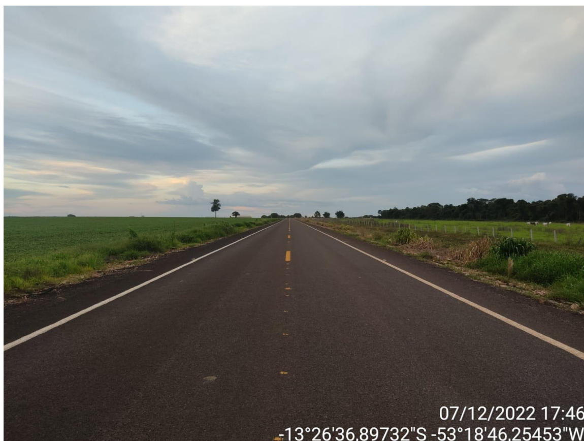
Figuras 137 e 138 – trecho não pavimentado da MT 129.
