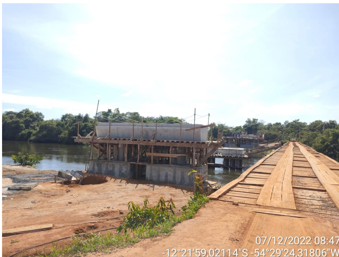
Figuras 90 e 91 – ponte sobre o Rio Von Den Steinen.
